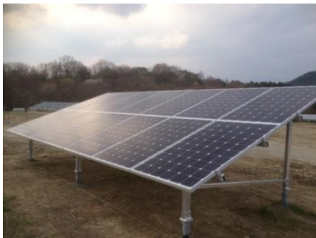
主要部材はアルミニウム合金を使用
