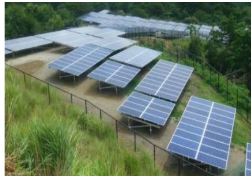
地面の起伏や形状に合わせた架台
