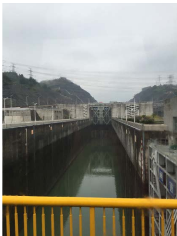
左航路に閉じた閘門
